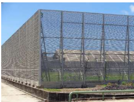
ภาพที่ 2.2-5 ผนังชะลอลมล้อมรอบพื้นที่กองเก็บ ถ่านหินกลางแจ้ง
