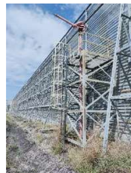
ภาพที่ 2.2-4 ระบบฉีดพรมน้ำบริเวณพื้นที่กองเก็บ เชื้อเพลิงถ่านหิน
