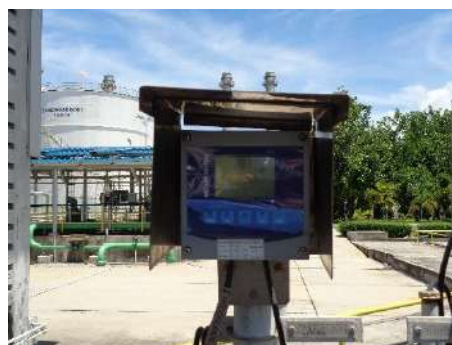
ภาพที่ 2.2-19 pH Meter แบบอัตโนมัติ บริเวณบ่อปรับสภาพกรด-ด่าง
