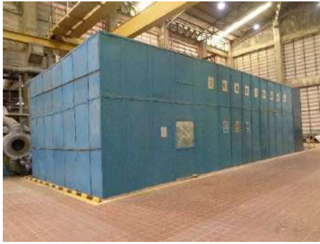
ภาพที่ 2.2-41 อุปกรณ์ลดเสียง Silencer และปิดครอบเครื่องจักรที่มีเสียงดัง
