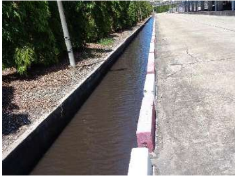
ภาพที่ 2.2-20 ร่องน้ำขนาดกว้าง 2 เมตร ลึก 1.5-2.2 เมตร ล้อมรอบกองถ่านหิน
