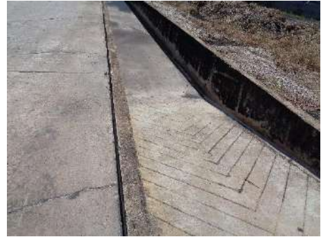
ภาพที่ 2.2-20 ร่องน้ำขนาดกว้าง 2 เมตร ลึก 1.5-2.2 เมตร ล้อมรอบกองถ่านหิน
